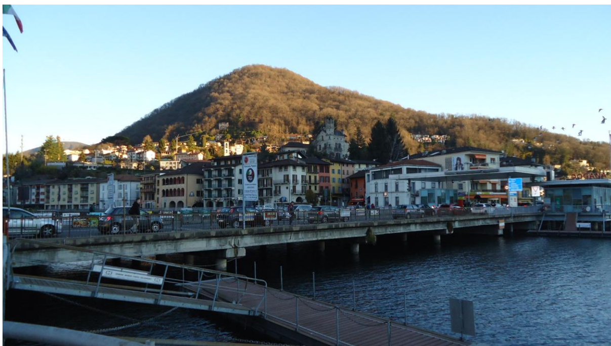
PONTE SUL FIUME TRESA E PONTE TRESA SVIZZERA
